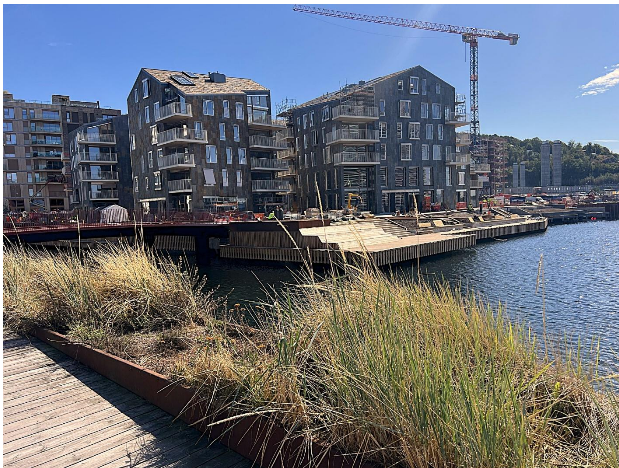
Byggefelt B6b – Vannkunsten syd- under oppføring.
